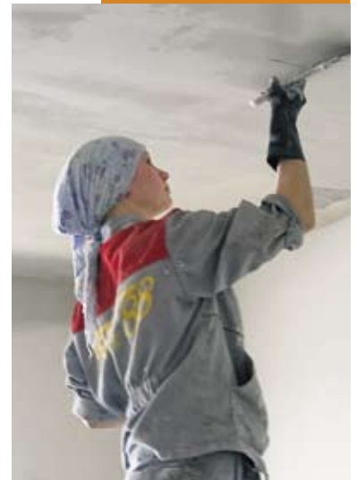
На строительных подмостках девушки похожи на античные скульптуры. Шпатлевку потолка заканчивает Екатерина Зудова.
